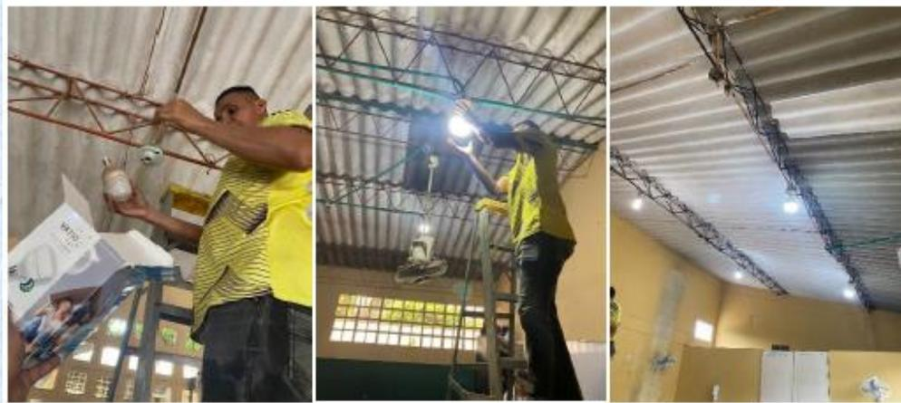
**Reparación de luminarias en jaula múltiple, salones y patios utilizaciones de bombilla de 50V , reflectores de 400V Y 200V, cable centelsa # 12, reparación de luces, reparación de abanicos, suiches, interruptores, y tomacorrientes, Aires acondicionados en sala de informática.**
